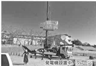
発電機設置中 (クレーン)
